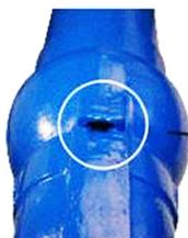
Poteau fermé (image 1) : le clapet libère l'orifice de vidange et l'eau s'évacue gravitairement.
