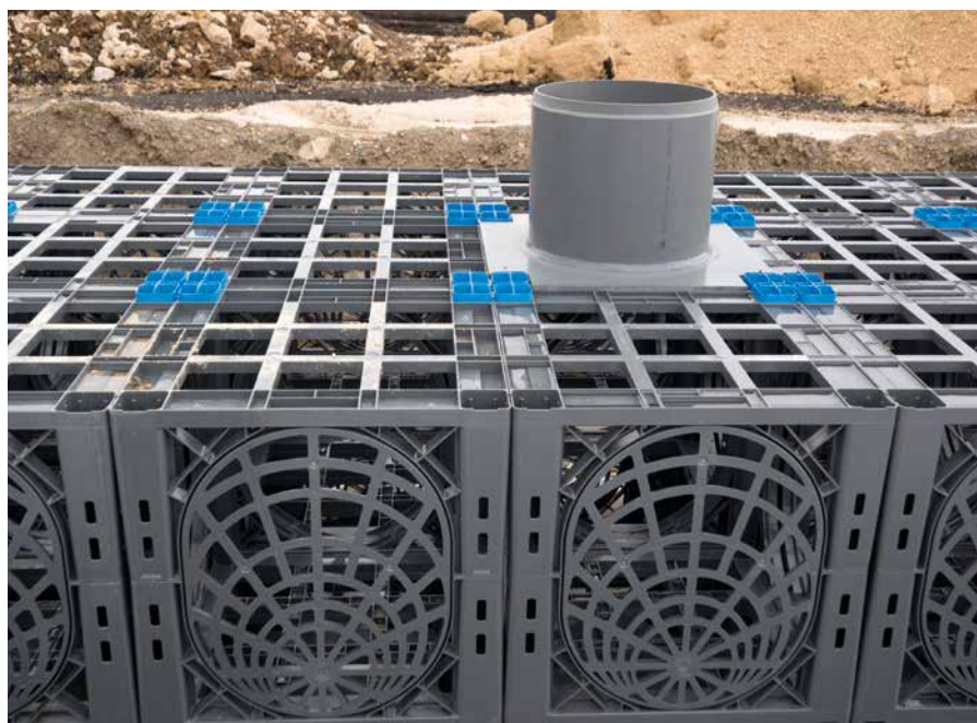
> Bloc d'inspection avec raccordement d'un tube de réhausse DN 400 pour l'entretien
