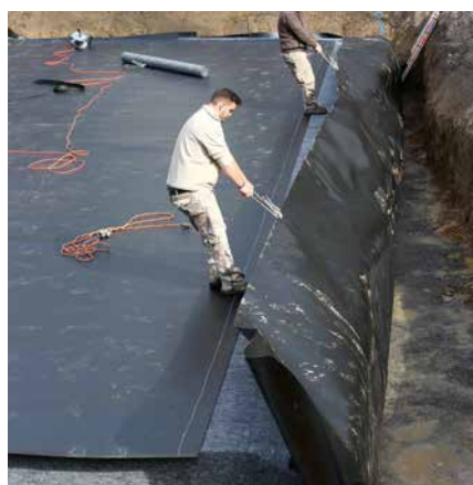
Installation de grande envergure avec un enveloppement dans une géomembrane
