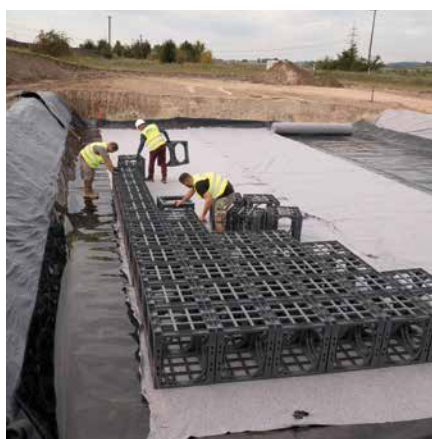
Installation de grande envergure avec un enveloppement dans une géomembrane
