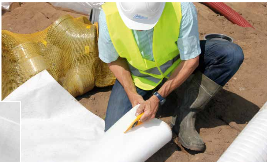
Découpe du géotextile avec l'outil de découpe Funke
