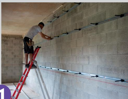
Clipser les flèches dans les fourrures horizontales tous les 60 cm, ou les fixer directement au mur en cas de rénovation.
