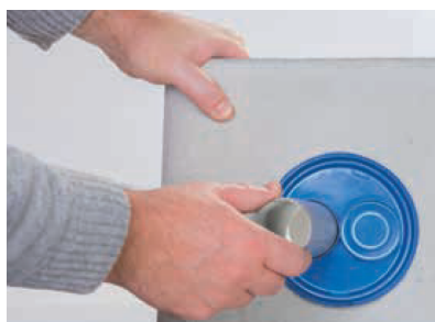
3 Passer le tuyau de raccordement (gaine électrique ou de télécommunication)
