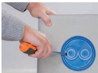
1 Ouvrir l'opercule avec un tournevis
