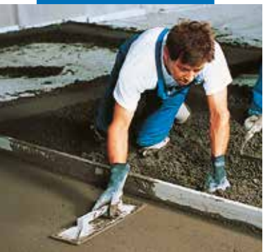
Finition par talochage du mélange Mapecem
