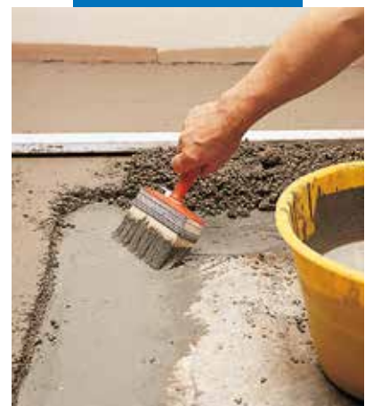
Application de la barbotine d'accrochage pour chape adhérente Mapecem
