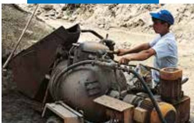
Malaxage et pompage de Mapecem avec une installation automatique
