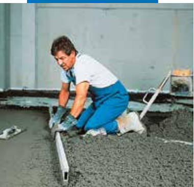
Étalement etamage du mélange Mapecem
