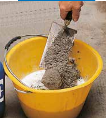
Préparation de la barbotine d'accrochage composée de Mapecem et Planicrete
