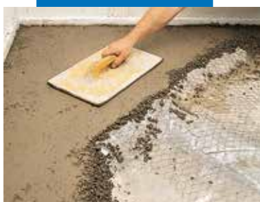
Recouvrement des tuyaux ou canalisations avec un treillis métallique de renfort
