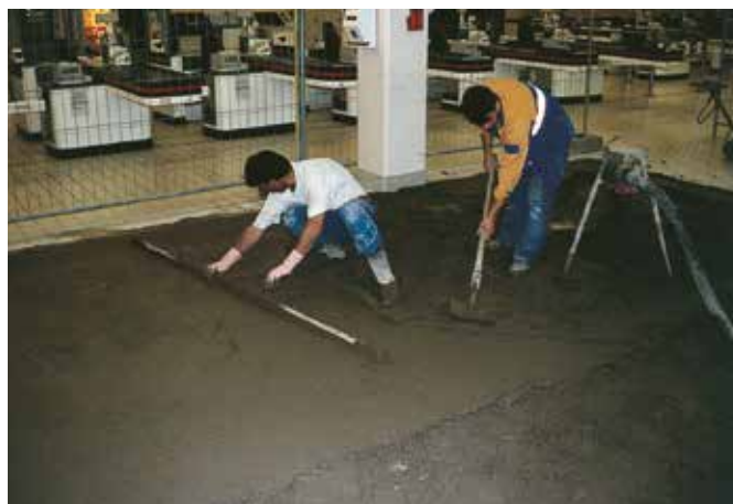
Réparation rapide d'une chape dans un supermarché
