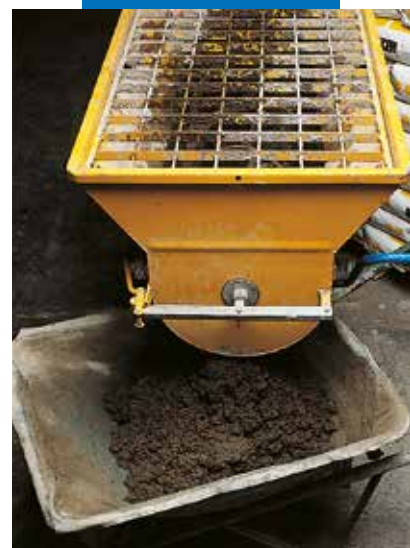
Malaxage de Mapecem avec un malaxeur horizontal
