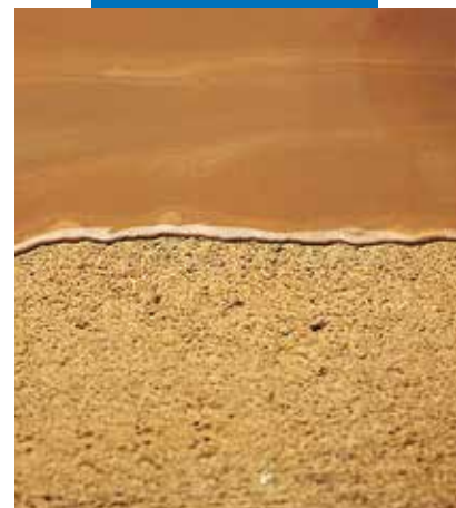
Application de la barbotine d'accrochage pour chape adhérente Mapecem
