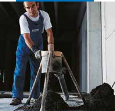
Alimentation du mélange Mapecem
