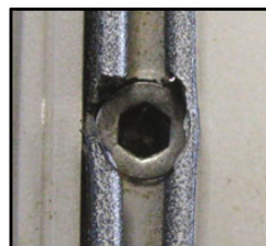
4. Vis Top-Roc mise en place.
