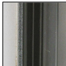
4. Joint de finition mis en place.
