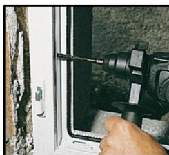
2. Percer un trou Ø 8 mm dans le mur à travers la menuiserie.
