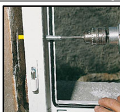
3. Enfoncer la vis Top Roc avec la cheville puis visser.
