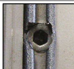
4. Vis Top-Roc mise en place.
