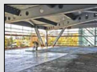
1 Béton structurel léger en argile expansée Laterlite.
