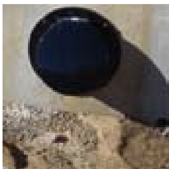
Bassin de rétention
