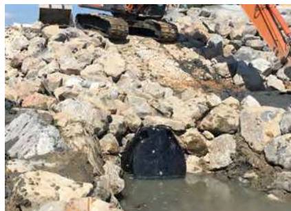
Clapets MULTI NB installés sur des berges
