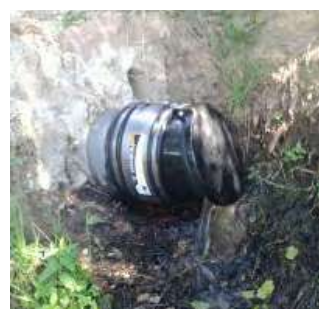
Clapets MULTI NB installés sur des berges, sur tuyaux PVC
