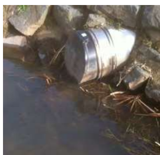
Clapets MULTI NB installés sur des berges, sur tuyaux PVC
