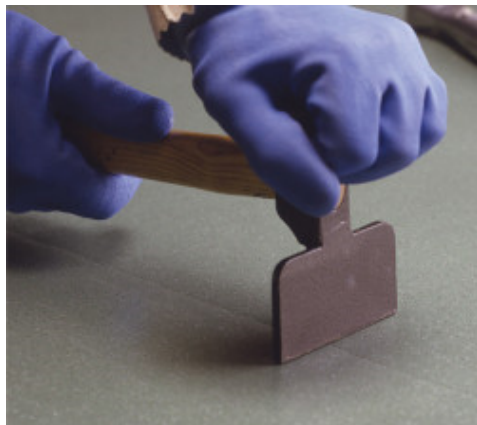
Appuyer sur la jonction entre les lés
