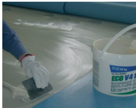
Application de l'Ultrabond Eco V4SP - Maison de repos de San Martino - Italie
