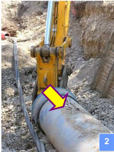
2 Repousser la jonction vers le fond d'emboîture pour amorcer le dégriffage des inserts métalliques du joint.
