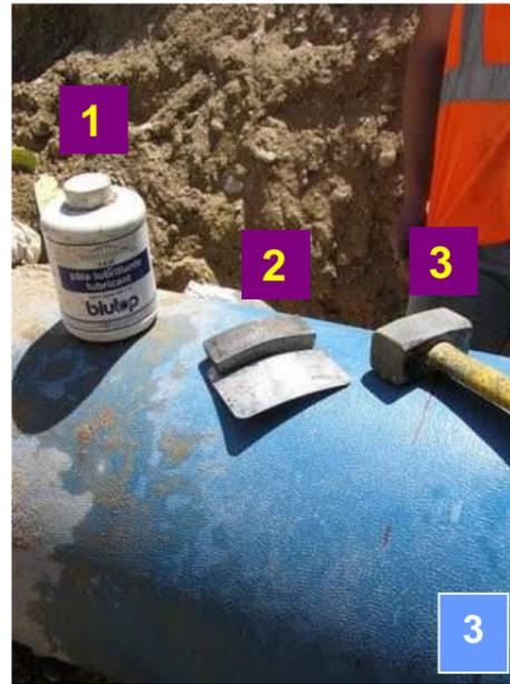
3 Préparer : la graisse à joint de tuyau, cale à frapper et tôles de déverrouillage, une masselotte.
