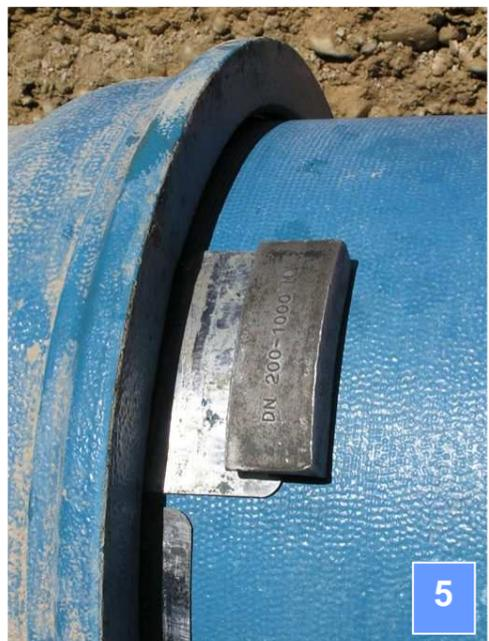
5 Présenter l'ensemble tôle + cale dans l'espace annulaire. Le grand côté de la tôle contre le joint.
