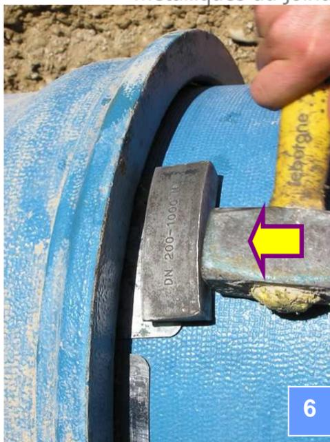
6 Frapper progressivement la cale en quinconce afin de faire pénétrer la tôle sous le joint. Plaquer la tôle sur le fût du tuyau si besion.
