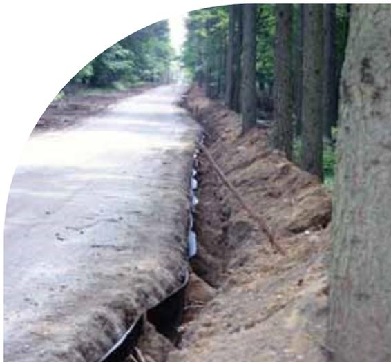
**Barrière de contrôle anti-racines pour protéger les bâtiments, les murs, les chemins, les routes d'accès, les canalisations de drainage et les câbles souterrains de dommages causés par les racines.**
