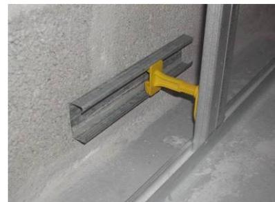
*Figure 17 - Pose avec rupteur de pont thermique – sens longitudinal*
