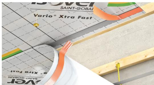
Membrane d'étanchéité à l'air hygro-régulante pré-adhésivée
