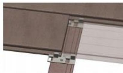
Le clip d'aboutage permet l'alignement de 2 lames qui se suivent et augmente le support de réception des extrémités de lames.
