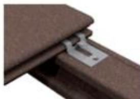
La première lame est positionnée, le clip vient se glisser sous la lame.
