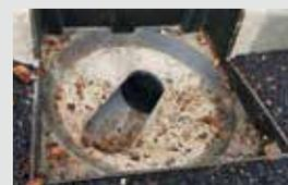
Pour une installation sur un collecteur de sortie d'avaloir non perpendiculaire à la paroi ou dans une cunette, la bague de butée doit être découpée (zone prédéfinie) et le collier d'expansion installé.
