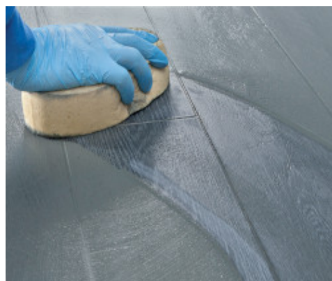
Nettoyage et finition des joints à l'éponge
