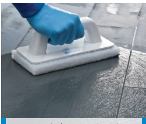
Nettoyage des joints en sol avec le PAD blanc (sur produit partiellement durci)
