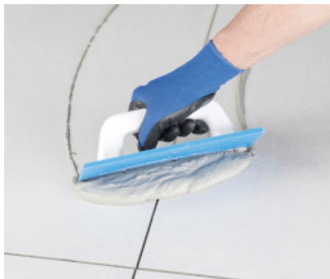
Jointoiement en mur avec la spatule caoutchouc
