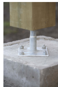
Fixation d'un pied de poteau
