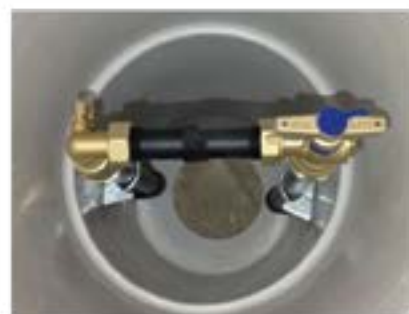
ISO CYL 300 V.PEHD : un compteur DN15 lg 110 mm
