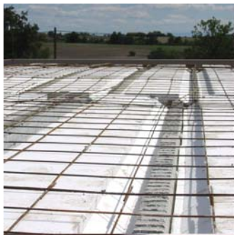
Pas de chute
