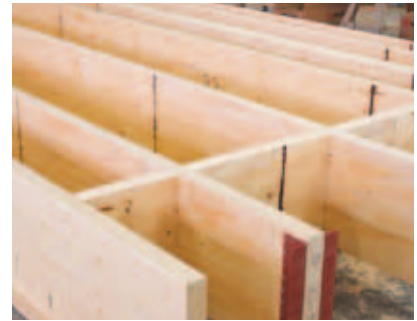
Préfabrication de dalle de plancher.
