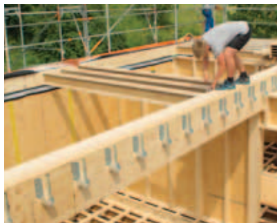
Poutre porteuse (peut se substituer au métal)
