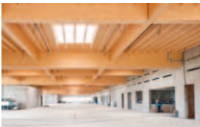
Toiture de l'aéroport de Kassel réalisée avec STEICO LVL.
