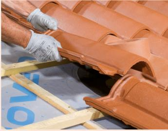
**1** - Déterminer le positionnement final de la tuile à douille. Enlever les tuiles du rang supérieur ainsi que la tuile voisine recouvrant la tuile à douille.
