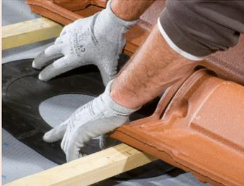
**5** - Découper la zone, sur l'écran de sous toiture, repérée préalablement. Fixer la membrane à l'aide de l'adhésif.
