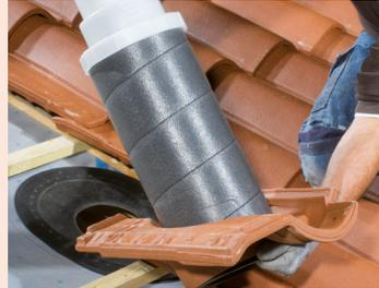
**6** - Mettre le manchon dans la tuile à douille, puis l'isolant et visser le raccord multi-diamètres. Fixer le collier de serrage autour du raccord.
