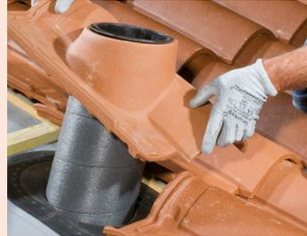
**7** - Positionner l'ensemble en s'assurant de la bonne étanchéité avec la membrane (si nécessaire, suivant la configuration de pose et du modèle de tuile, prévoir une découpe de la mousse).
