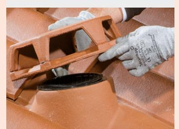
**8** - Positionner la grille anti intrusion et fixer la lanterne avec un mastic de collage sur la tuile à douille.
