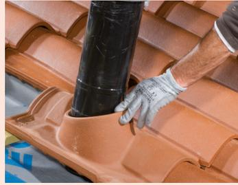
**2** - Positionner correctement le manchon au centre de la tuile à douille. Le sens d'inclinaison du manchon est indiqué par un repère.
