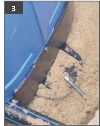
En cas d'instabilité, le corps enterré peut-être ancré au sol avec des fers à béton placés dans les orifices prévus à cet effet.
