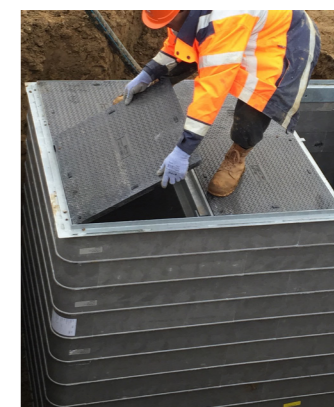
Pose / Dépose Tampons
