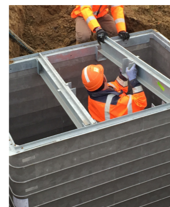
Pose / Dépose Traverses
