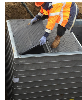
Pose / Dépose Tampons
