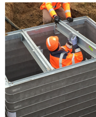
Pose / Dépose Traverses
