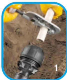
1. Découper le tube perpendiculairement à l'axe au moyen d'un coupe-tube adapté ; vérifier la propreté et le bon ébavurage de l'extrémité.
