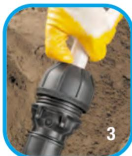
3. Insérer le tube jusqu'à la profondeur repérée.
