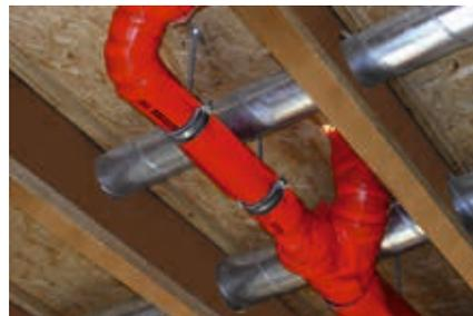
membrures (45,60,90 mm) facilitent le calepinage. La possibilité de passer des gaines techniques et les différents réseaux du bâtiment (VMC, fluides, évacuations) par simple percement de l'âme jusqu'à un diamètre de 200mm dans les poutres STEICOjoist réduit de manière importante les hauteurs de plénum. Alliées au STEICO LVL, les poutres en I STEICO permettent d'obtenir un rapport prix/performance compétitif pour les bâtiments résidentiels, tertiaires, industriels et agricoles.
