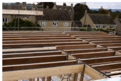
fibres de bois dure NFB. Les propriétés mécaniques des panneaux durs NFB sont supérieures aux panneaux courants du marché. On obtient ainsi des poutres STEICOjoist et STEICOwall d'une grande qualité, stables dimensionnellement et issues de matières premières végétales peu transformées. Leur légèreté et leur grande résistance mécanique en font un produit idéal pour les planchers, toitures et murs. Elles apportent des solutions économiques aux constructions neuves comme aux rénovations.
