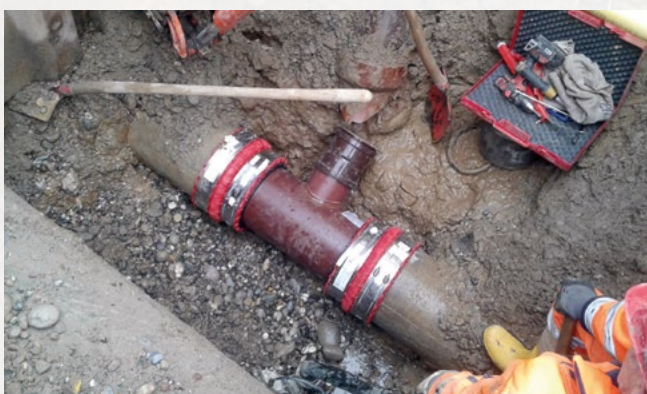
Ajout après coup d'un branchement de réparation (haut) ou d'un tube de réparation (bas) dans une conduite en grès déjà posée
