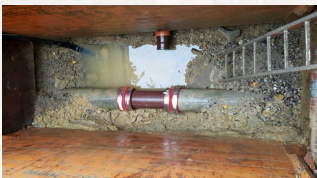
Ajout après coup d'un branchement de réparation (haut) ou d'un tube de réparation (bas) dans une conduite en grès déjà posée
