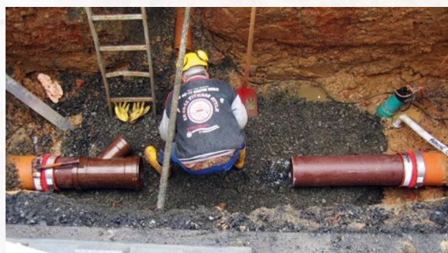
Réparation de conduites défectueuses
