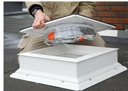
Installation du module extérieur
