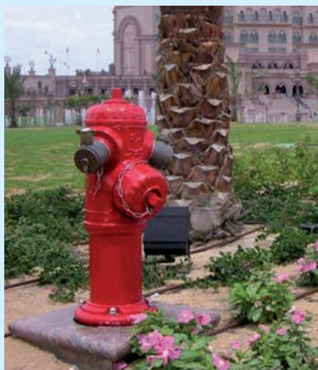
Poteaux équipés de prises conformes aux normes souhaitées
