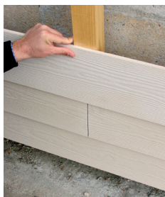
⑤ Pose, rangée par rangée en décalant les joints
