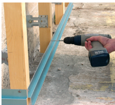
① Mise en place du profil de départ
