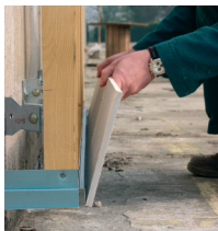
② Pose et fixation de la première rangée de clins
