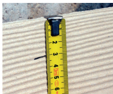
③ Recouvrement de 30 mm
